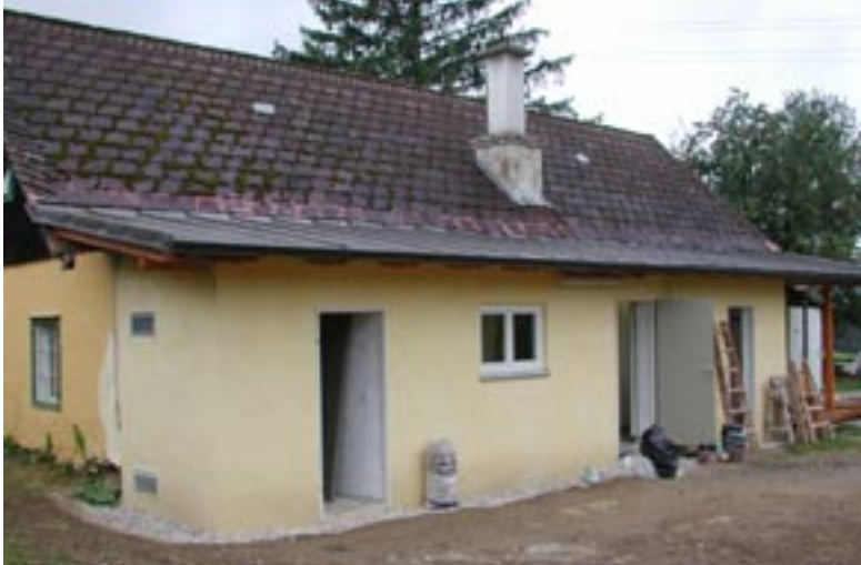
Haus Thernberg bei den Bauarbeiten im Jahr 2002
