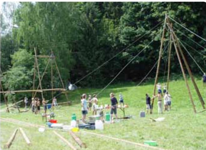
Das Errichten dieses Hochbaus mit knapp 10 Metern Höhe war eine Herausforderung.
